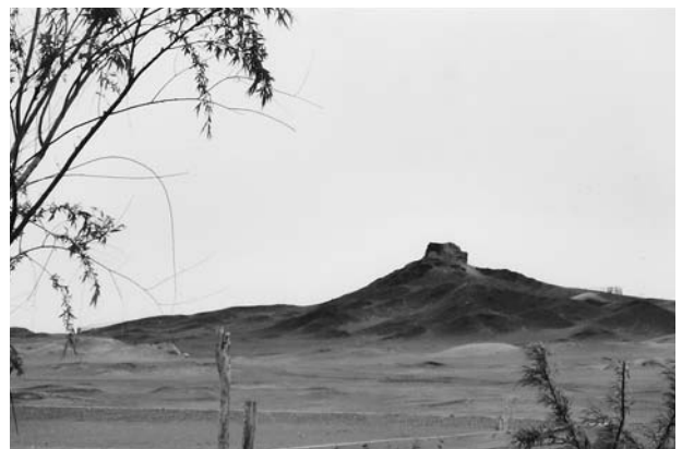
写真6、陽関門からの狼煙台
